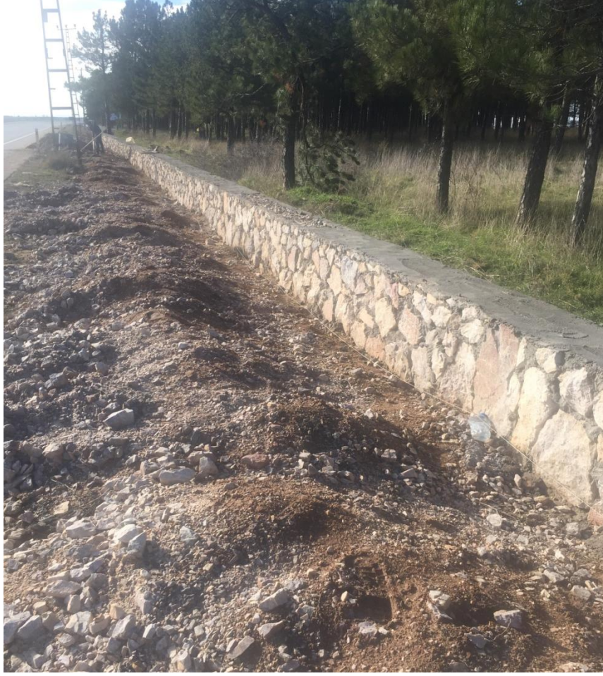
Taş Duvar Yapım İşi
