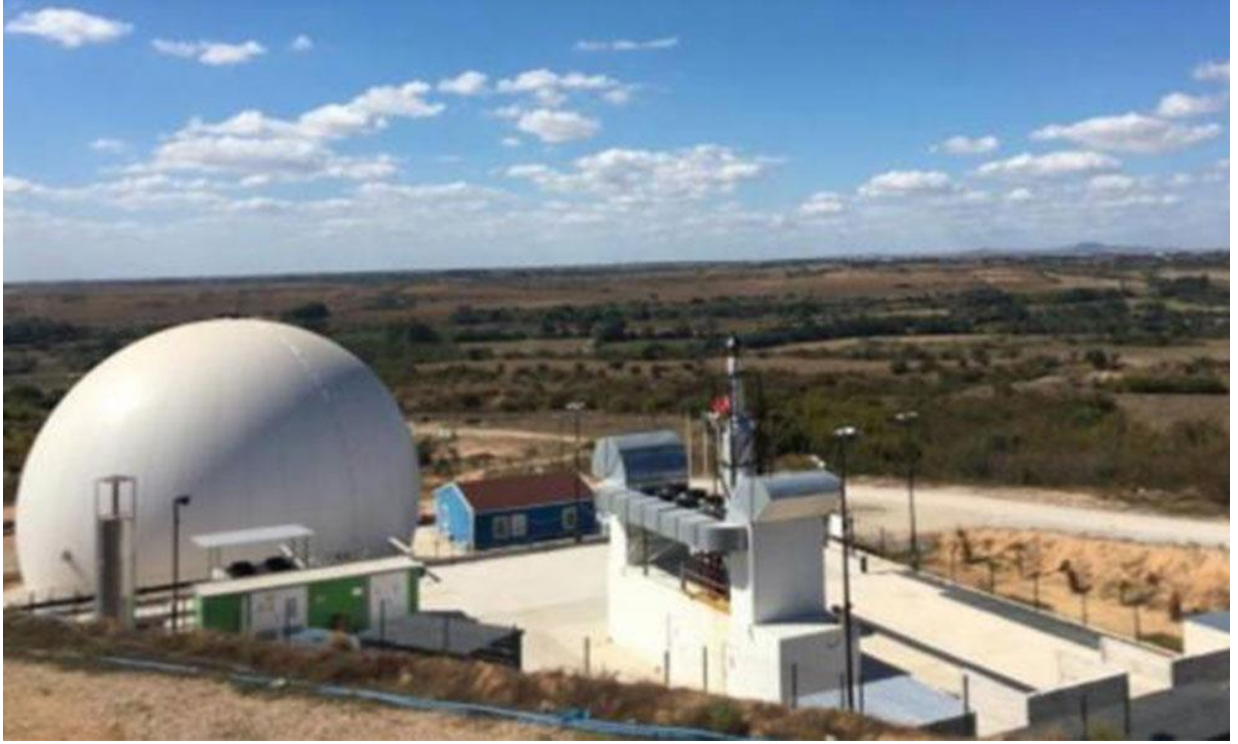
Şekil 13 KIRK-KAB Katı Atık Düzenli Depolama Tesisi
