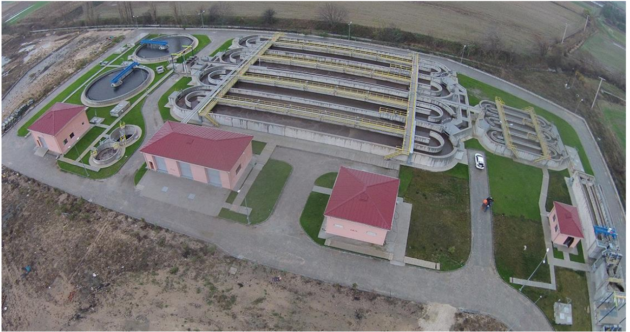
Şekil 14 Kırklareli Merkez Atık Su Arıtma Tesisi
